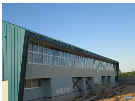
平成28年完成新体育館
